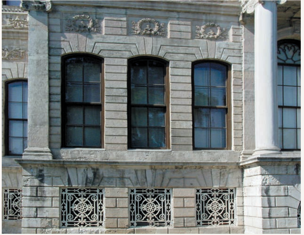
Resim 2a-2b-2c-2d Dolmabahçe Sarayı dış cephelerinde kullanılan tüfler
