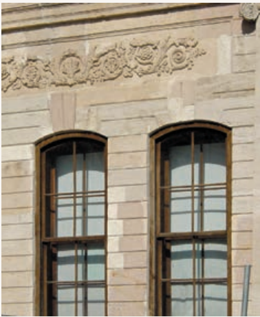
Resim 2a-2b-2c-2d Dolmabahçe Sarayı dış cephelerinde kullanılan tüfler
